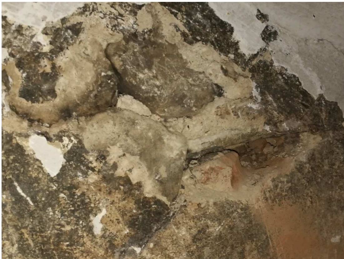
Detail kamenné vyzdívky v místě sondy (nad záklenkem)
