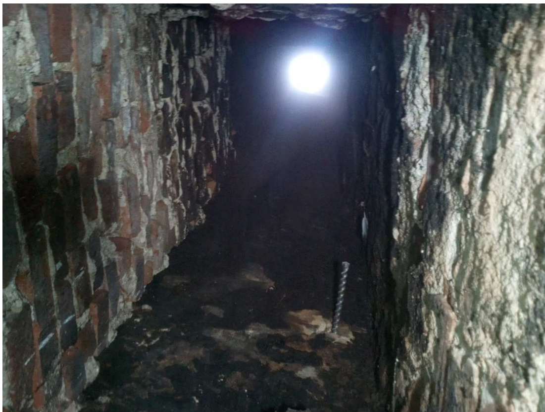
Vyústění sondy s vrtákem do stávajícího nepoužívaného komínu (budoucí spalínová cesta pro odkouření nových kotlů)
