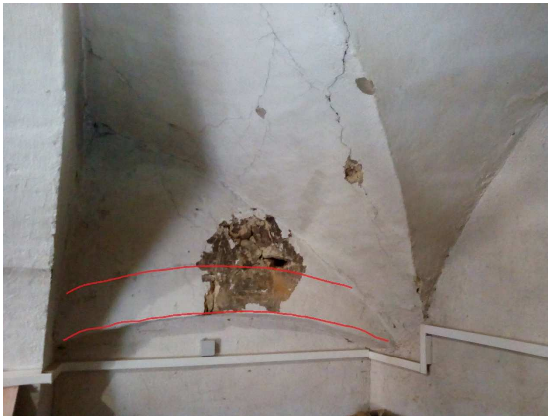
Pozice odvrtané sondy a předpokládaný průběh cihelného záklenku v budoucí kotelně
